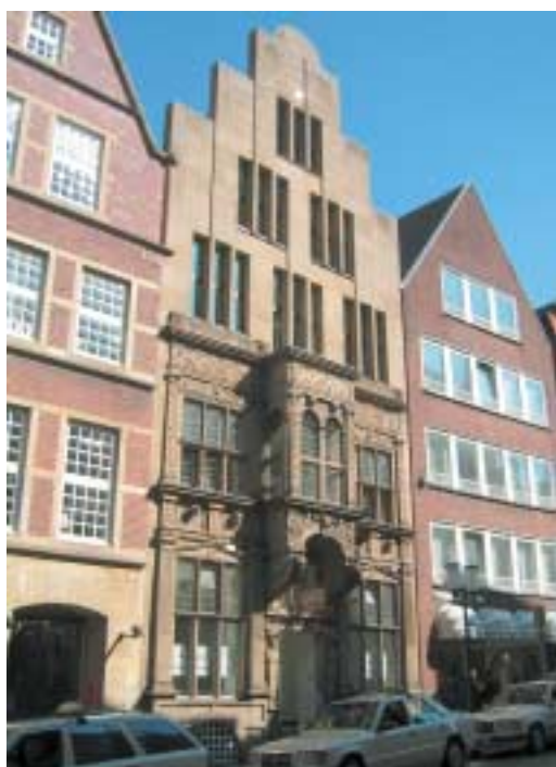
Schlaflos im Keller des ehemaligen Bankhauses – das „Insonnia“.
